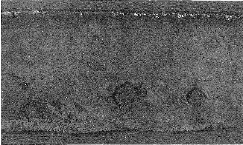
Fig. 8. Udsnit af varmtvandsbeholder af ubeskyttet stål, alder 3 år. Rusttuerne er fjernet, og man ser de dybe grubetæringer.
